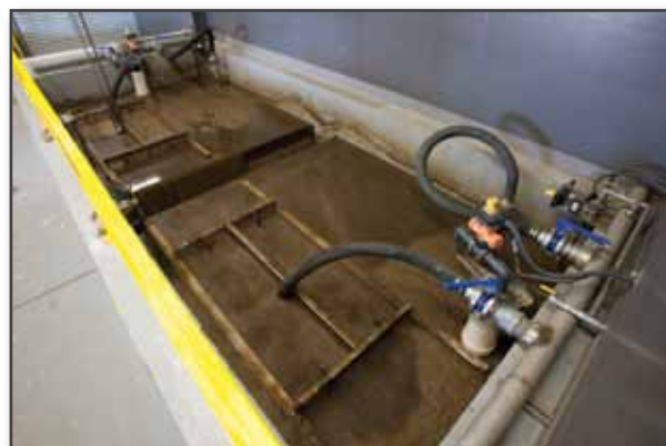
Quechan Casino's membrane module in air scour mode.
